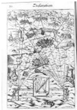
Figura 5. Técnica de medición angular y lineal mediante *intersecciones*, haciendo uso del grafómetro, sugerido por Danfrie (1597).
