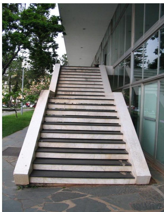
Figura 3. Escada da Reitoria da UFMG, Belo Horizonte, Brasil. Paralelas.
